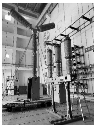
图17 72.5 kV真空断路器额定短时耐受电流试验、额定峰值耐受电流试验状态图
